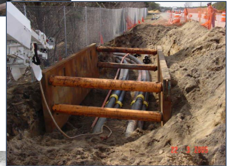
Conduit Installation
